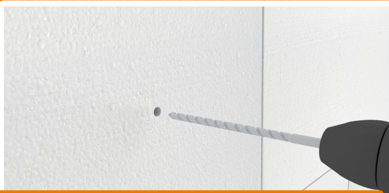
Wywiercenie otworu pod BOLIX KWM. Głębokość kotwienia i średnica wiertła powinny być dobrane indywidualnie do podłoża i węzła mocującego
