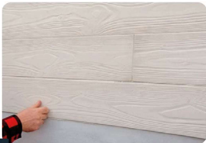
Fot. 2 - NAKLEJANIE PANELI
