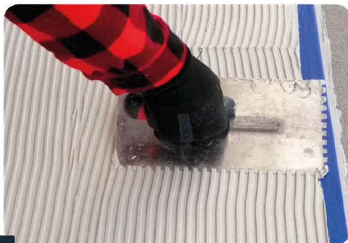
Fot. 1 - NAKŁADANIE MASY KLEJĄCEJ
