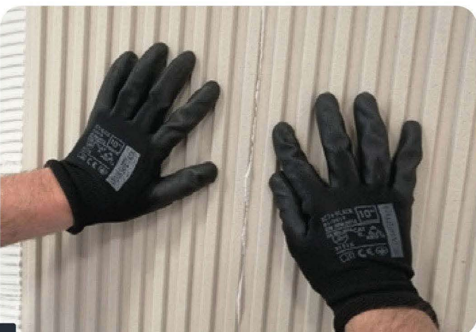
Fot.4 ŁĄCZENIE PANELI
