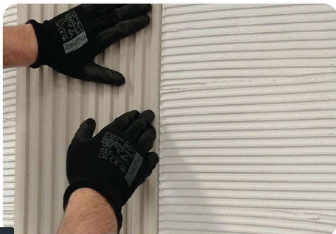
Fot.2 NAKLEJANIE PANELI
