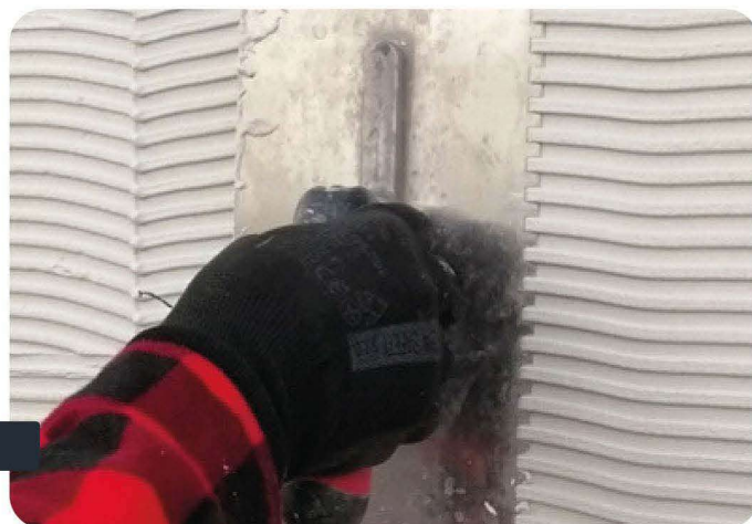
Fot.1 NAKŁADANIE MASY KLEJĄCEJ
