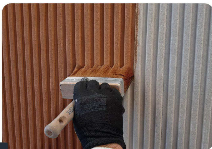
Fot.6 NAKŁADANIE FARBY BOLIX SIL W WYBRANYM KOLORZE
