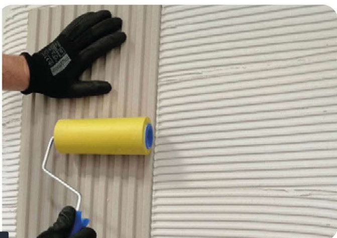
Fot.3 DOCISKANIE PANELI WAŁKIEM
