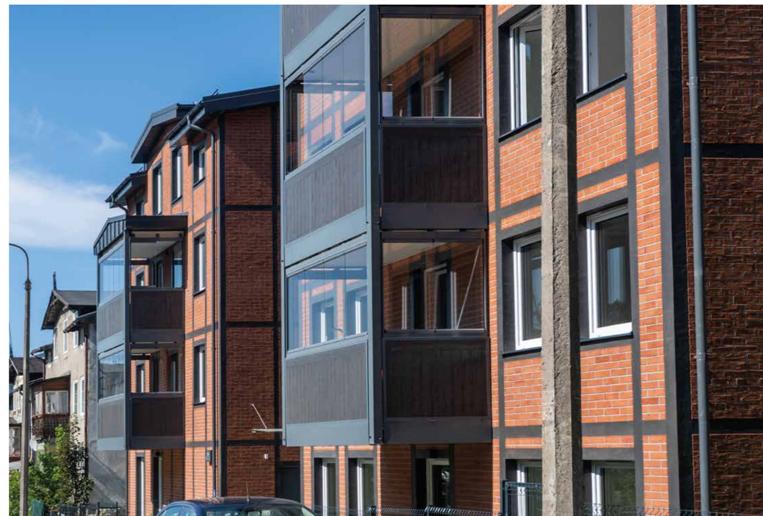
GDAŃSK, UL. WRONIA
