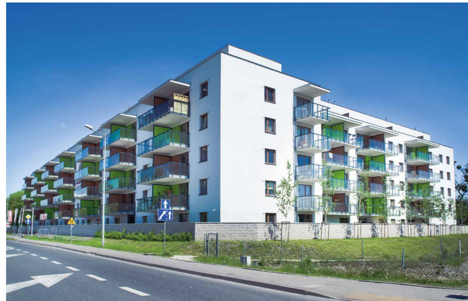
WARSZAWA, UL. DYWIZJONU 303 UNIBEP S.A.
