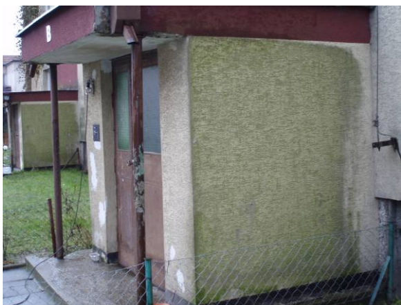
fot. 74. Ściana porażona glonami (algami) fot. 75. Nakładanie preparatu BOLIX GLO complex
