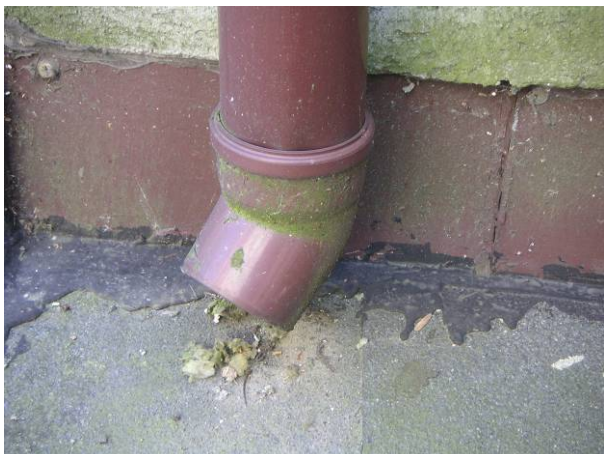
fot. 21. Rynna PCV i blacha powlekana.
