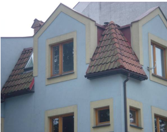
fot. 26. Dachówka cementowa.
