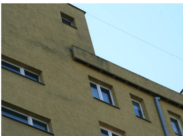
fot. 39. Tynk cienkowarstwowy typu „kornik”
