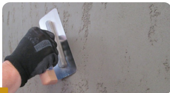
Fot.4. UŻYCIĘ PACY WENECKIEJ PO WSTĘPNYM WIĄZANIU W CELU UZYSKANIA GŁADKIEJ POWIERZCHNI
