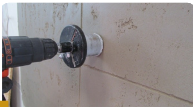
Fot.6 NAWIERCANIE IMITACJI STOŻKÓW ŚCIĄGÓW SZALUNKOWYCH
