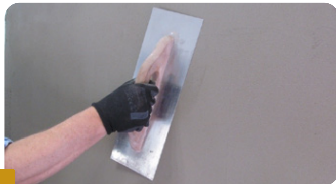
Fot.2 WYGŁADZANIE CAŁOŚCI SZEROKĄ PACĄ, ZCOWUJĄC RÓWNIOMIERNĄ GRUBOŚĆ ZAPRAWY
