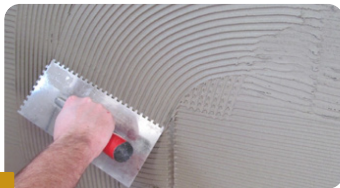
Fot.1 RÓWNIOMIERNE NANOSZENIE BOLIX TBR ZA POMOCĄ PACY Z GRZEBIENIEM O WYSOKOŚCI 6 MM
