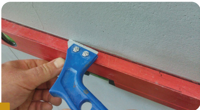
Fot.5 WYCINANIE IMITACJI ŁĄCZENIA PŁYT BETONOWYCH ZA POMOCĄ SKROBAKA DO FUG.
