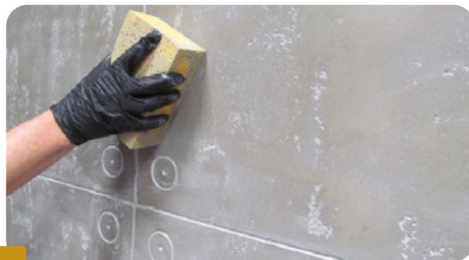
Fot.8 ROZPROWADZANIE BOLIX DECO LAUR ZA POMOCĄ WILGOTNEJ GĄBK
