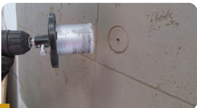
Fot.7 WIERTŁO KORONKOWE DO WYCINANIA IMITACJI STOŻKÓW ŚCIĄGÓW SZALUNKOWYCH
