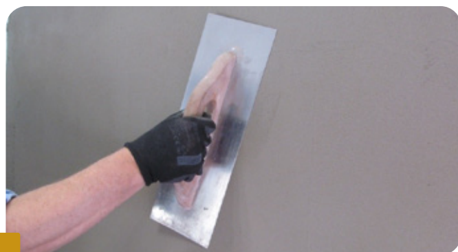
Fot.2 WYGŁADZANIE CAŁOŚCI SZEROKĄ PACĄ, ZCOWUJĄC RÓWNOMIERNĄ GRUBOŚĆ ZAPRAWY
