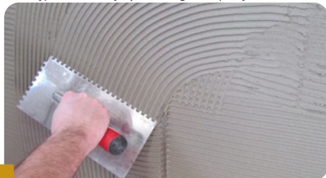
Fot.1 RÓWNOMIERNE NANOSZENIE BOLIX TBR ZA POMOCĄ PACY Z GRZEBIENIEM O WYSOKOŚCI 6 MM
