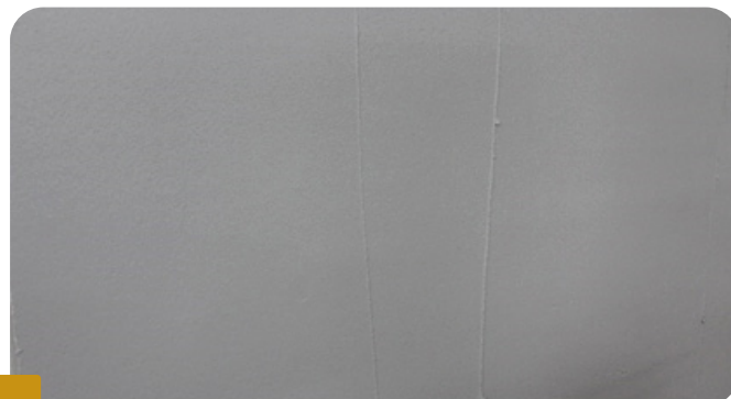
Fot.2. WYSCHNIĘTY TYNK BOLIX TR PRZED SZLIFOWANIEM – WIDOCZNE ŚLADY PO PACY
