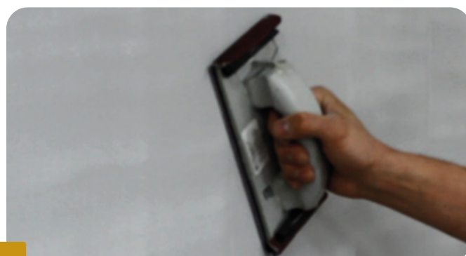
Fot.3. SZLIFOWANIE POWIERZCHNI ZA POMOCĄ PACY Z PAPIEREM ŚCIERNYM.
