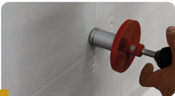
Fot.5. NAWIERCANIE IMITACJI ŚLADÓW PO KOTWACH.
