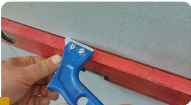
Fot.4. WYCINANIE IMITACJI ŁĄCZENIA PŁYT BETONOWYCH ZA POMOCĄ SKROBAKA DO FUG.
